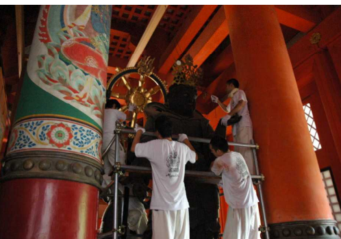
堂内に足場がぐまされ、解体が始まります
