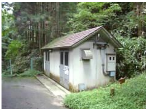
図 5 南谷中継ポンプ場
