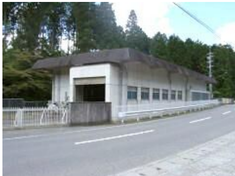
図 3 中ノ橋中継ポンプ場
