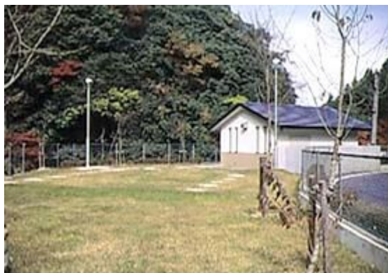
図 7 不動谷浄化センター
