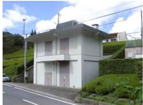
図 4 鶯谷中継ポンプ場
