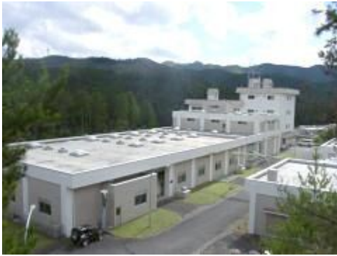
図 2 高野山下水処理場
