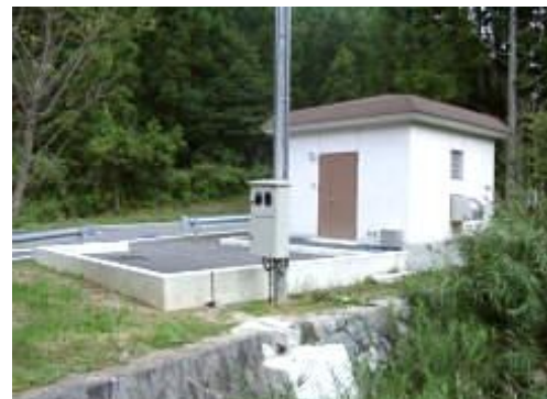
図 6 転軸山ポンプ場
