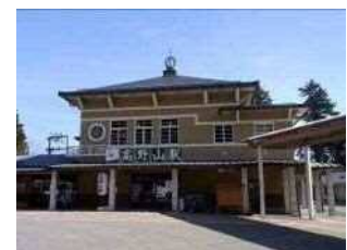
南海電気鉄道鋼索線 高野山駅駅舎
