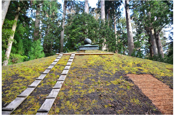
重要文化財 金剛峯寺奥院経蔵 修理前屋根近接
