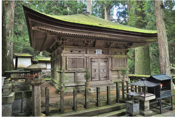
重要文化財 金剛峯寺奥院経蔵 修理前全景
