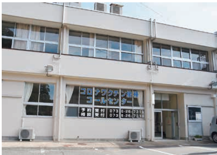
コールセンター外観
