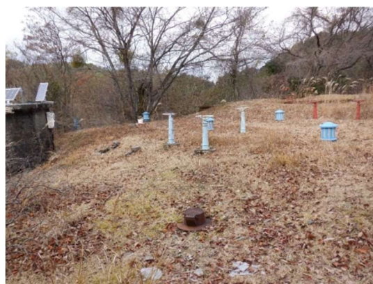
【相ノ浦配水池（地下）】
