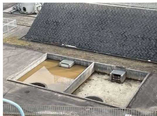
【天日乾燥床(高野山浄水場)】
