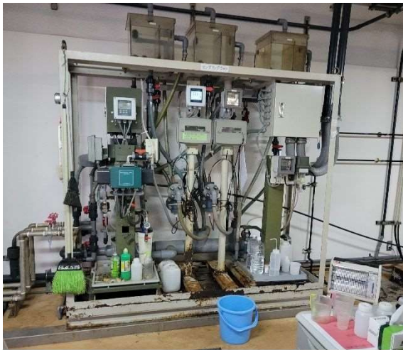
【水質自動計測装置(高野山浄水場)】
