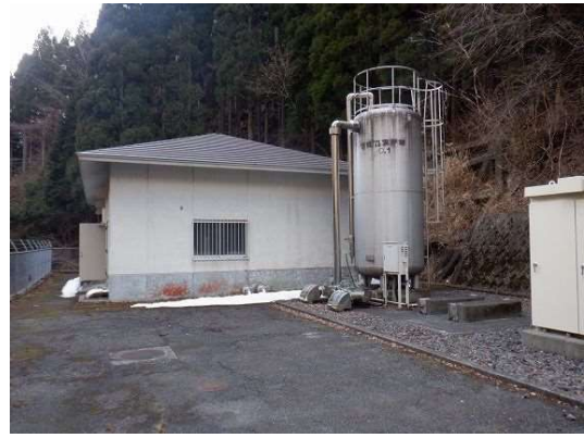
【相ノ浦浄水場】
