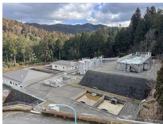
【高野山浄水場】
