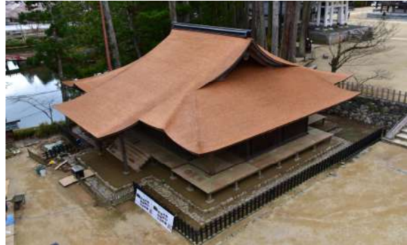
国宝 金剛峯寺不動堂 修理状況(左:檜皮葺替状況 右:修理完了状況)
