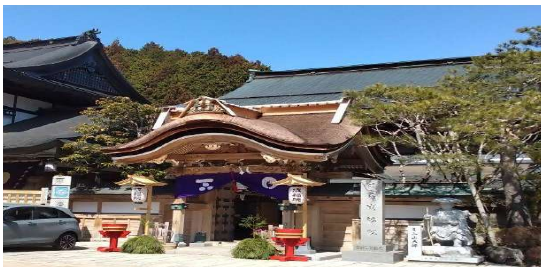
令和6年度 美しい街なみ景観整備事業による整備 成福院山門屋根改修工事
