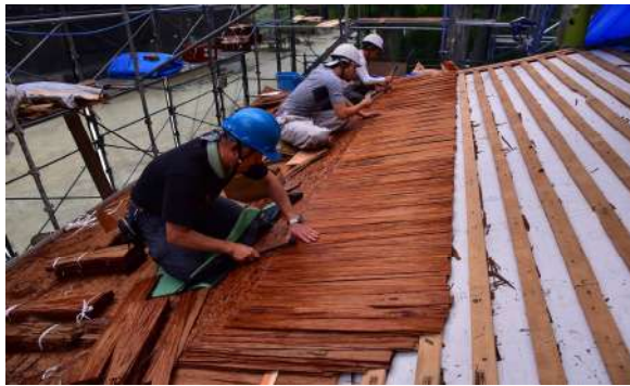
国宝 金剛峯寺不動堂 修理状況(左:檜皮葺替状況 右:修理完了状況)
