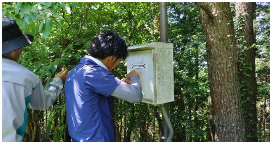
防火設備の点検状況(文化財防災用貯水槽)
