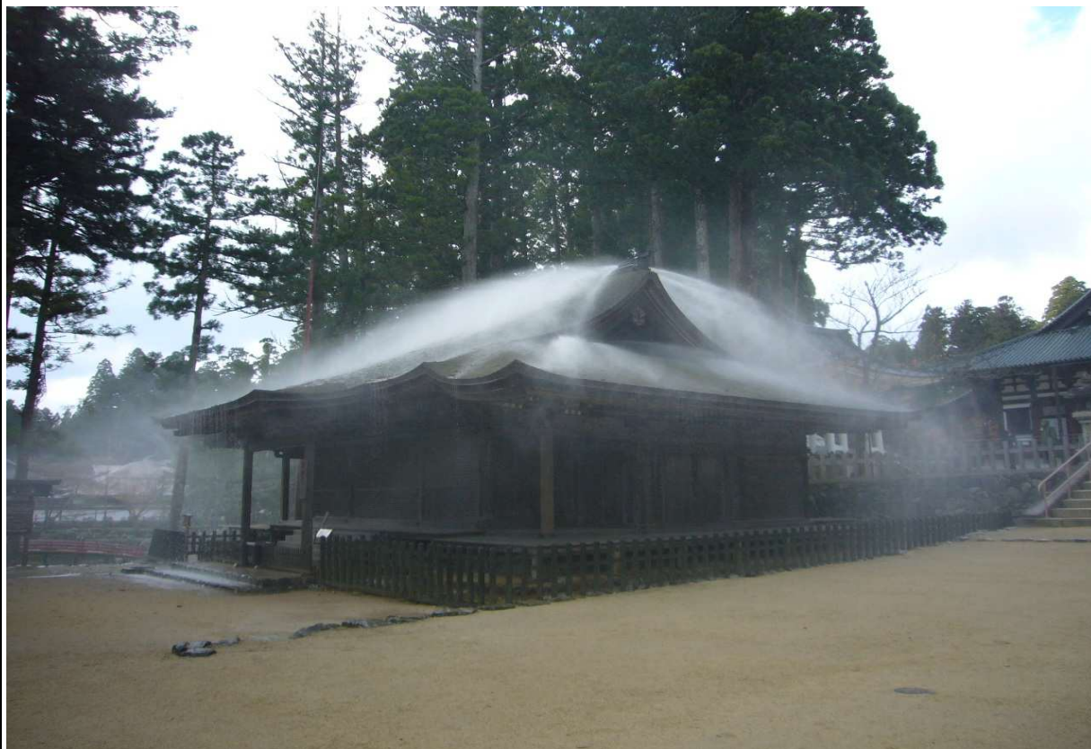
防火設備の点検状況(金剛峯寺不動堂)
