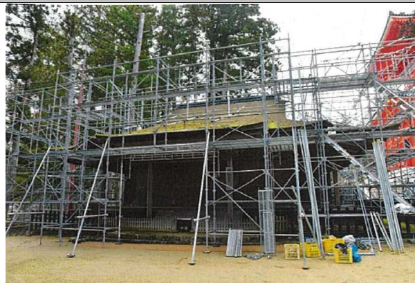
国宝 金剛峯寺不動堂 修理状況(左:素屋根建設 右:檜皮の解体)
