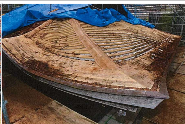
国宝 金剛峯寺不動堂 修理状況(左:素屋根建設 右:檜皮の解体)
