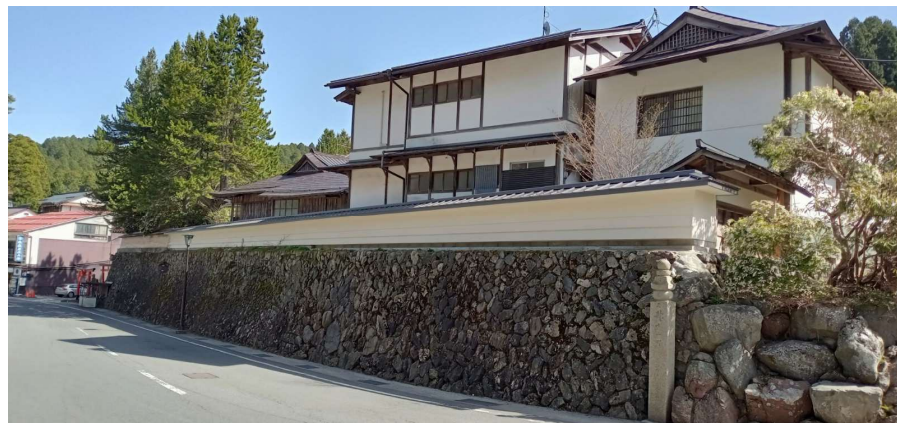
令和4年度 美しい街なみ景観整備事業による整備 北室院塀改修工事
