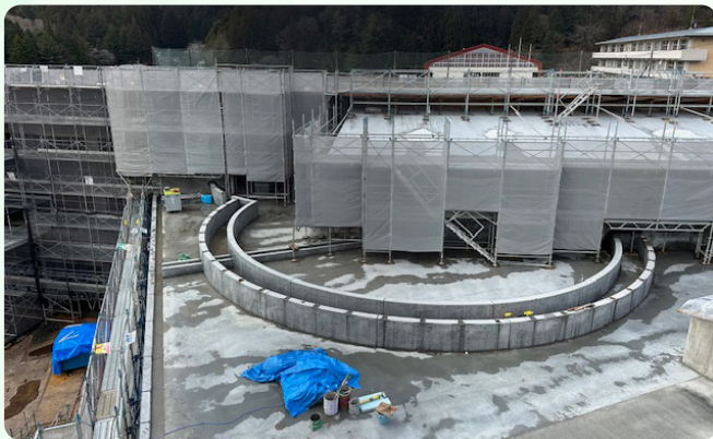
施設全体工事状況写真
