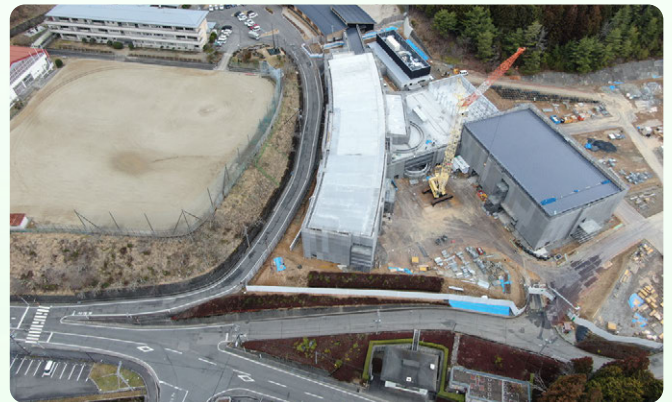
屋外広場工事状況写真
